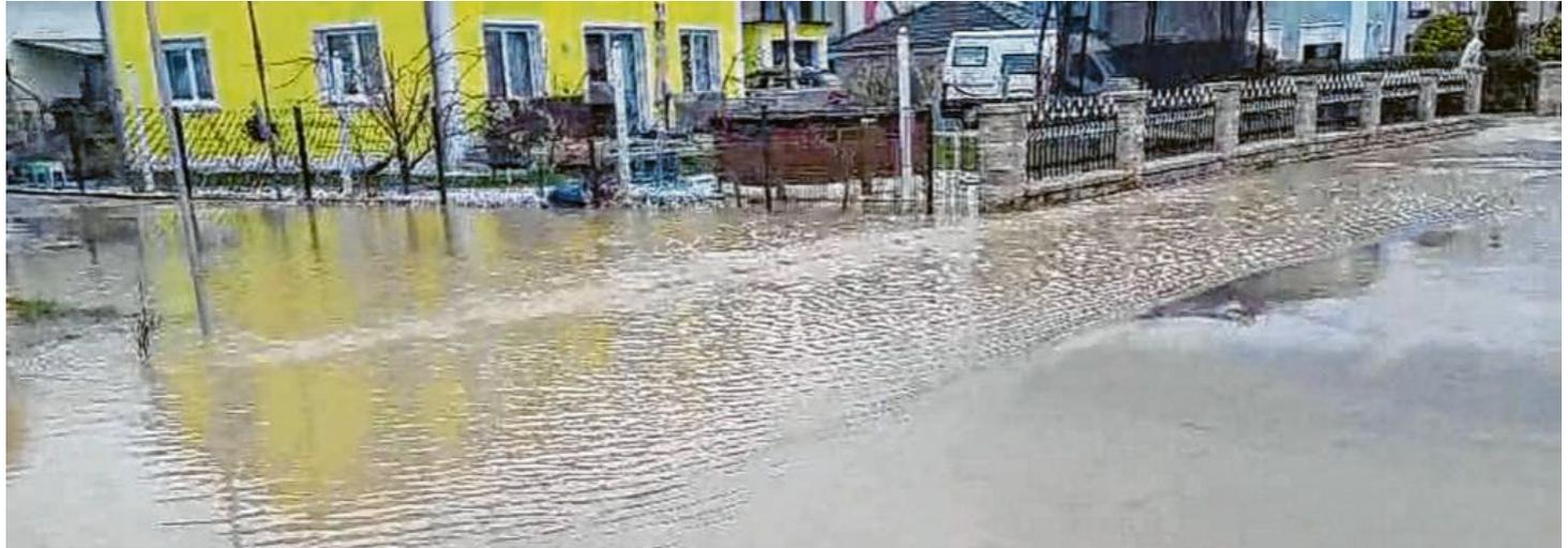
Mitte März sah es im Nordendorfer Neubaugebiet aus wie in einem Überschwemmungsgebiet. Das Wasser auf den Straßen stammte aus einer gerissenen Trinkwasserleitung. Nur zwei Tage später riss dieselbe Leitung an einer anderen Stelle im Ortsteil Blankenburg. Jetzt wurde beschlossen, dass die Leitung mit Inlinern saniert wird. Foto: WZV
